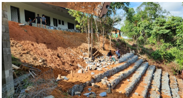
Er moet veel erosiepreventie worden aangelegd voor bijna elk gebouw dat we bouwen.
