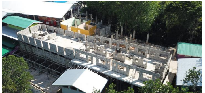
Vloeren en muren voor het twee verdiepingen opslag, groot naaiatelier, winkeltje en 13 huizen in aanbouw.
