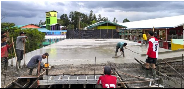
Een van onze geweldige teams die 27 uur non-stop beton stort. Wat een prestatie.
