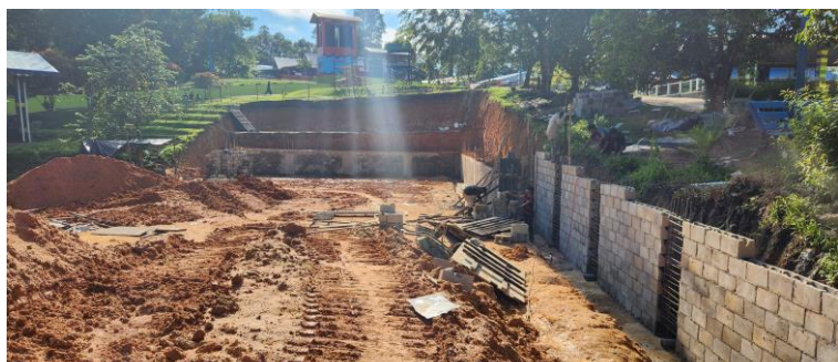
Het egaliseren van het gebied en het bouwen van keurmuren voor het nieuwe schoolgebouw met 6 klaslokalen voor de basisschool.
